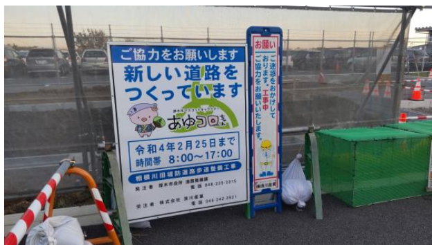
最初の下見では工事中であった。(2021/11)
