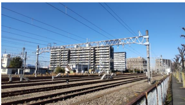
厚木駅裏の相鉄の線路。(2021/11)
