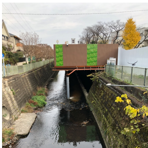
図 9：掘込式貯水池の工事の様子
